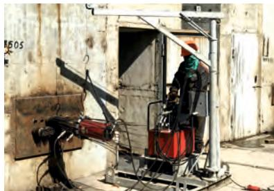
Предназначен для натяжения высокопрочной проволоки при армировании железобетонных балок, при ремонте и модернизации мостовых и гидротехнических сооружений, для усиления строительных конструкций. Управление натяжителем выполняется с насосной станции.
